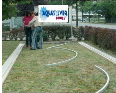
De onderste profielen geplaatst...
